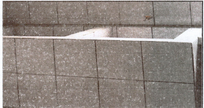
Foto 2: Elaboracion de pila dentro de la cocina
